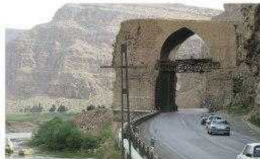
پل دختر اندیشک
