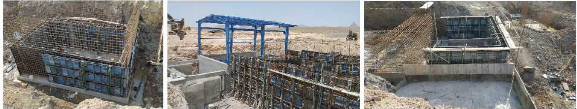
عملیات اجرایی سه ماهه اخیر ایستگاه ها:
