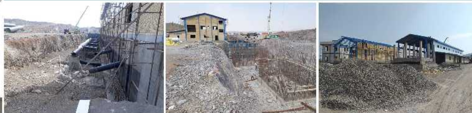
عملیات اجرایی سه ماهه بهار ۹۹ در ایستگاه ها:
